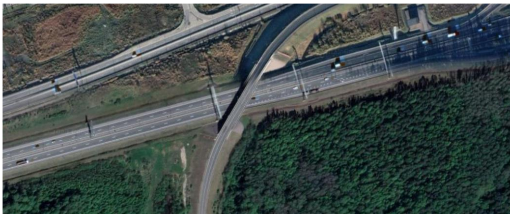
Рисунок 4.12– Место проведения испытаний (КАД. от ЗСД до Приморское ш.)
