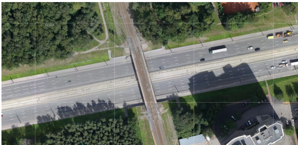
Рисунок 4.8– Место проведения испытаний (пр. Испытателей. г. Санкт-Петербург) 3 полосы движения на проезжую часть.
