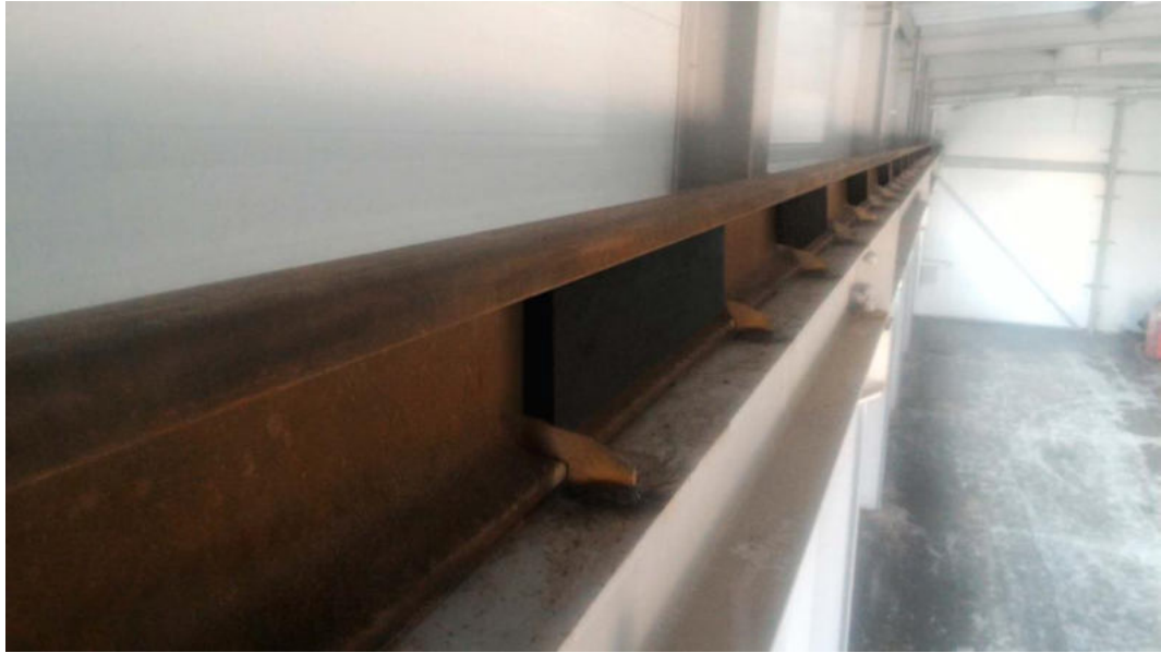
Рисунок 6.6 – Система вибропоглощения рельсов мостового крана
