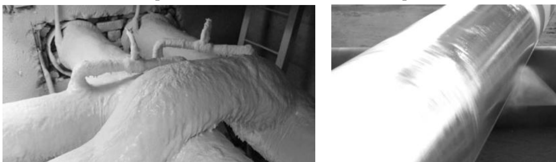
Рис. 15. Напыленная интегральная пенополиуретановая теплоизоляция трубопроводов (слева); напыление на поверхность теплоизоляции отражающего лакокрасочного покрытия (справа)
