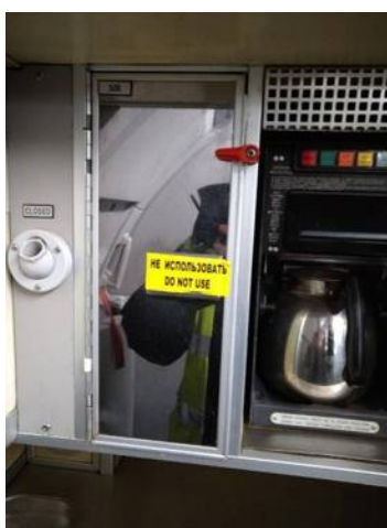
Рис. 2. «Неисправный» отсек кухни
