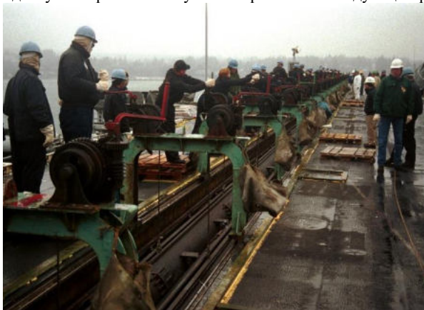
Рисунок 4. Ремонт паровой катапульты на палубе американского авианосца. Работы выполняются в базе после вскрытия палубы гражданскими специалистами с помощью большого количества специализированной оснастки, требующей одновременного применения ручного труда со стороны более сотни рабочих.
